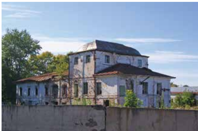
Здание Кирилло-Афанасиевской церкви. Фото 2011 года
