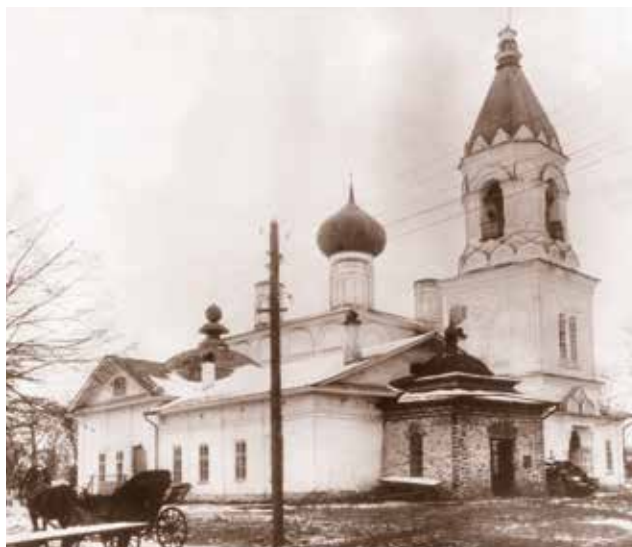
Успенский собор с теплой церковью Преподобного Сергия Радонежского. Фото 1926 года
