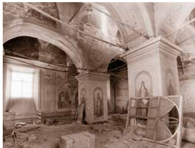
Фрагмент интерьера верхней церкви на уровне окон второго света. Фото 1983 года
