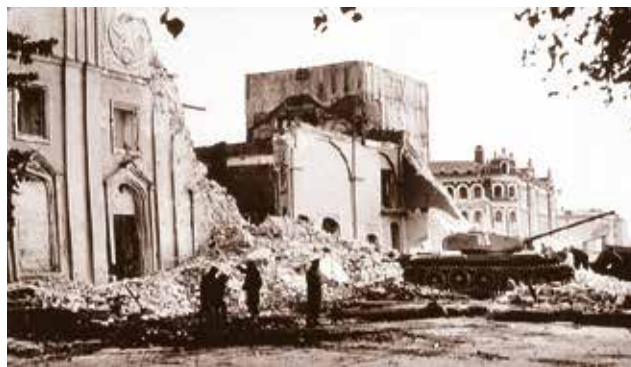
Разрушение здания Спасо-Всеградского собора. Фото 1972 года из собрания ВГИАХМЗ (нв 15307)
