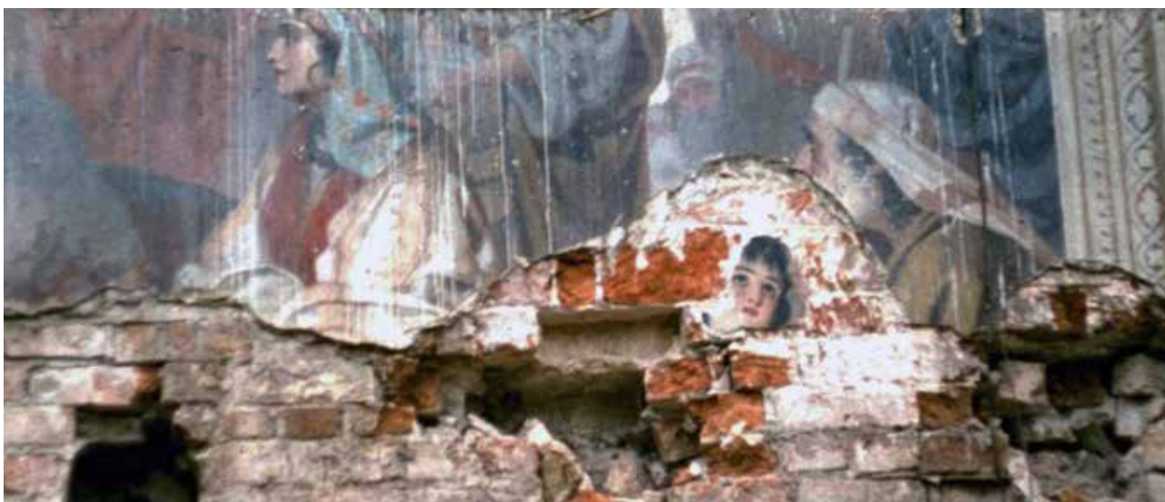
Фрагмент одной из росписей Спасо-Всеградского собора. Фото сделано во время разрушения здания в 1972 году
