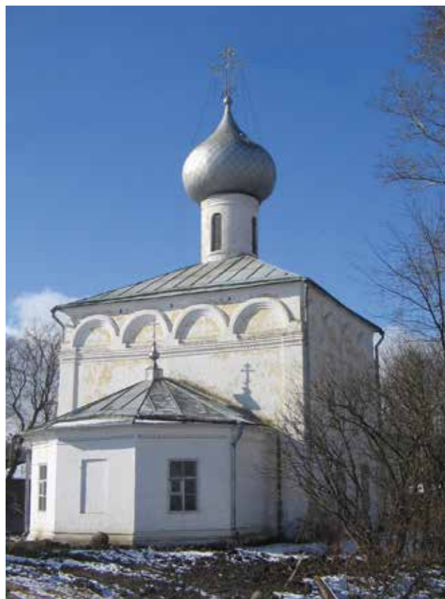
Ильинская церковь. Фото 2009 года
